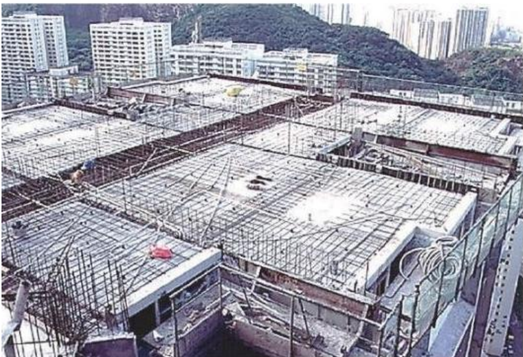
Fig. 38 Semi-precast slab
